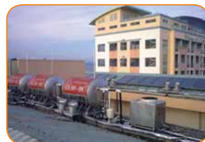
Hệ thống máy nước nóng năng lượng mặt trời Khách sạn Cap Saint Jacques - Vũng Tàu (Nguồn: en.bk-idse.com)
