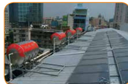
Hệ thống máy nước nóng năng lượng mặt trời Khách sạn Majestic, Tp. HCM (Nguồn: en.bk-idse.com)
