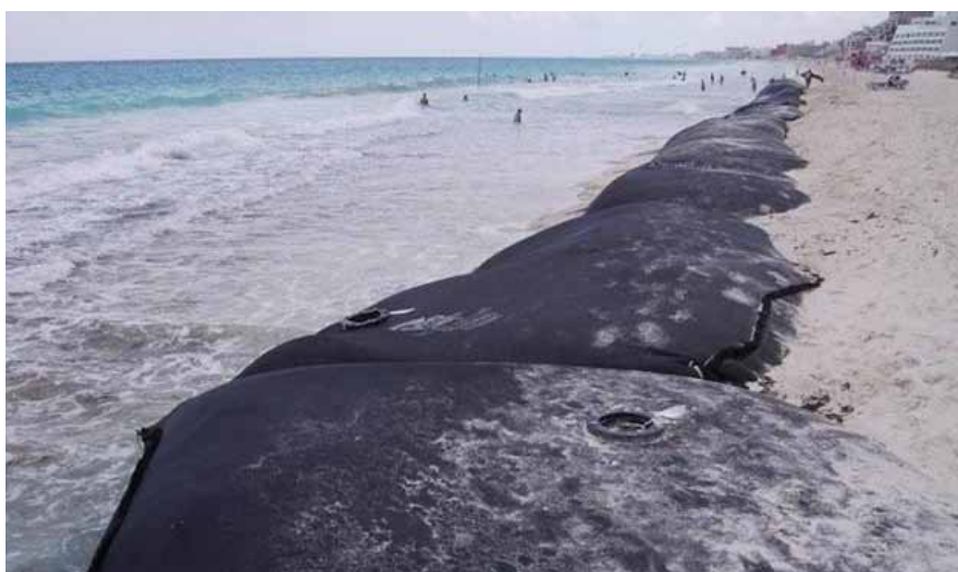
Tổng cộng 1.24 dặm ống Geotube® được sử dụng bảo vệ khẩn cấp bờ biển.
