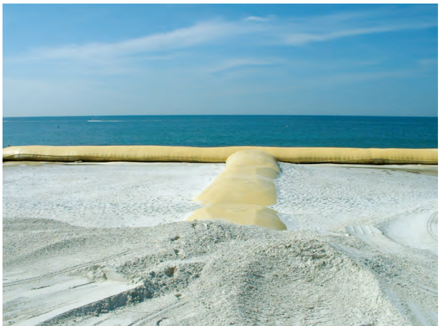
Những con đê hình chữ T sử dụng công nghệ Geotube® Containers tại bãi biển Upham đã ngăn chặn được tình trạng xói lở và tái tạo lại bãi biển, tình trạng xói lở này đã làm tiêu tốn hơn 10 triệu USD hằng năm.
