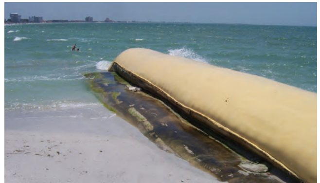
Ống Geotube® khi lắp đặt xong.
