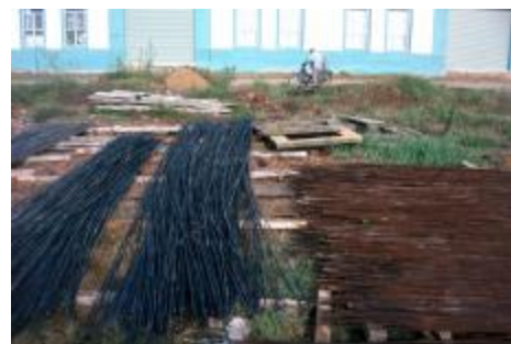
Hình 5. Gỉ thép và phun chất biến đổi gỉ xử lý gỉ thép
