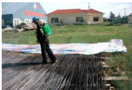
Hình 5. Gỉ thép và phun chất biến đổi gỉ xử lý gỉ thép
