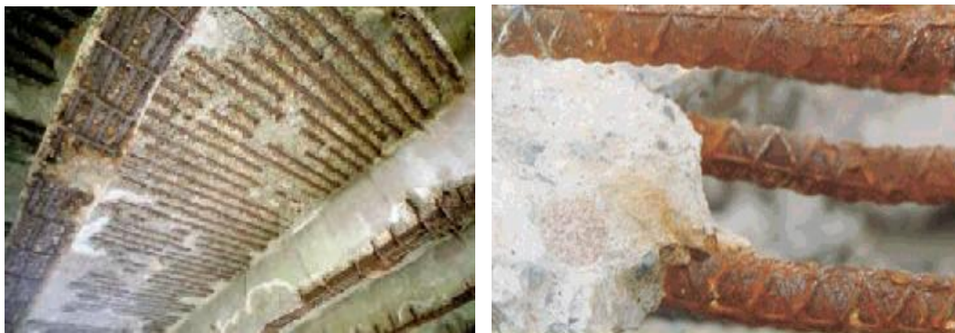
Hình 1. Hiện tượng gỉ thép và phá hủy kết cấu bê tông cốt thép
