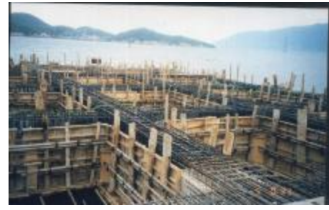
d. Cốt thép dầm sau khi xử lý
