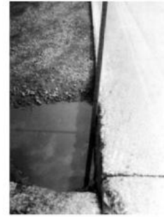
(H): Chênh cao giữa mặt đường và lề > 100 mm.
