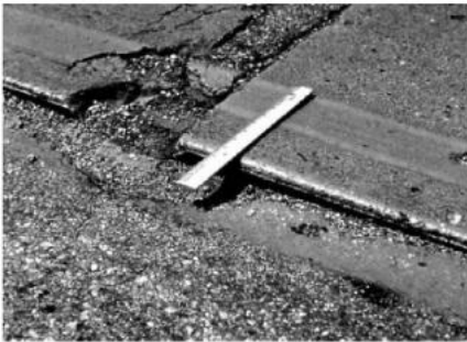
(L): Chênh cao giữa mặt đường và lề từ 20 mm đến 50 mm.
