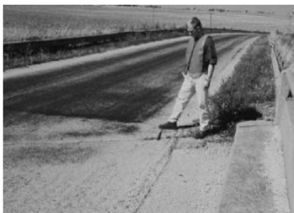
(L): Mặt đường nhựa bị đẩy trôi, dòn nhựa, nhưng không ảnh hưởng đến chất lượng chạy xe.
