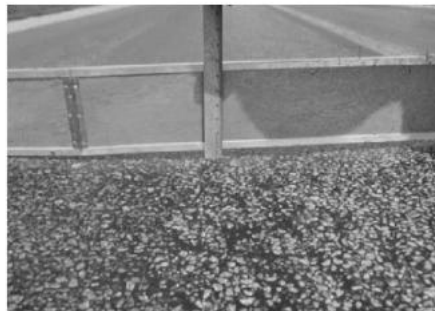
(M): Chiều sâu vết lún từ 13 mm đến 25 mm.
