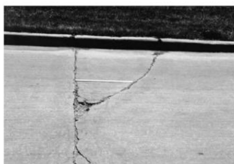
(M): Vết nứt rộng từ 13 mm đến 50 mm, hay vết nứt bất kỳ và tấm có hiện tượng lún tại vị trí nứt.
