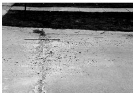
(L): Rộp vỡ gây ảnh hưởng ít đến chất lượng chạy xe.
