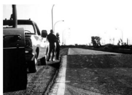
(H): Rộp vỡ, ảnh hưởng nghiêm trọng đến chất lượng chạy xe, xe không chạy được tốc độ.
