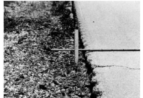
(H): Độ chênh cao giữa mặt đường và lề đường > 100 mm.
