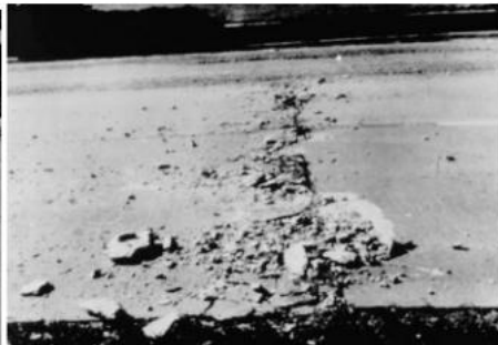
(M): Rộp vỡ ảnh hưởng đến chất lượng chạy xe, lái xe thấy xóc.
