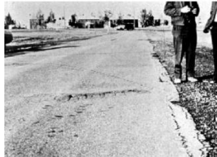
(M): Hiện tượng lỗi lõm ảnh hưởng đến chất lượng chạy xe. Người điều khiển phương tiện thấy khó chịu do mặt đường bị xóc.
