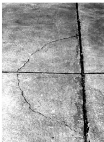
(L): Nứt tại góc tấm, bề rộng vết nứt < 13 mm, tấm không lún.
