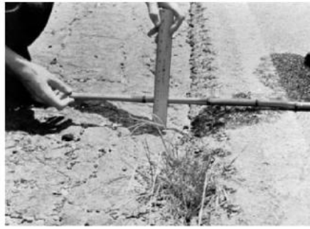
(M): Độ chênh cao giữa mặt đường và lề đường từ 50 mm đến 100 mm.
