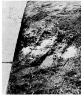
(M): Chênh cao giữa mặt đường và lề từ 50 mm đến 100 mm.
