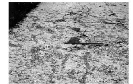
(H): Toàn bộ mặt đường bị nứt rạn, khoảng > 15% diện tích mặt đường bị bong vỡ.
