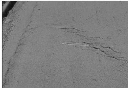
(M): Chiều rộng vết nứt từ 10 mm đến 40 mm, hoặc xung quanh vết nứt có hiện tượng bong bột hoặc có nứt thứ cấp.
