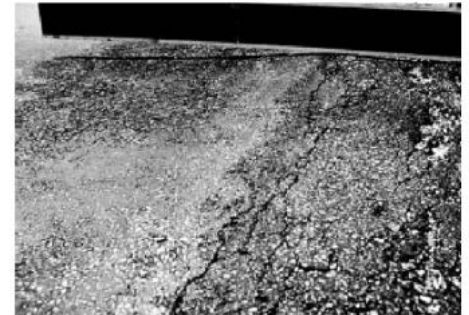
(H): Hiện tượng lỗi lõm ảnh hưởng nghiêm trọng đến chất lượng chạy xe. Lái xe không thể chạy với tốc độ cao trên các đoạn lỗi lõm.
