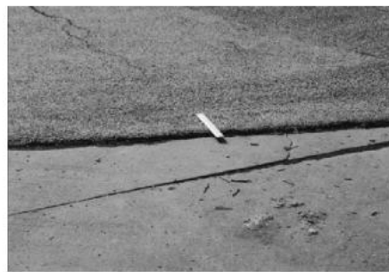
(M): Mặt đường bị đẩy trôi dòn nhựa, ảnh hưởng đến chất lượng chạy xe. Lái xe thấy khó chịu do xóc.
