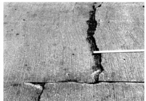
(H): Vết nứt thẳng rộng > 50 mm, lún tấm > 10 mm.
