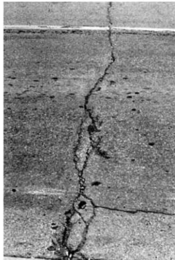
(M): Vết nứt có chiều rộng > 10 mm, bắt đầu có hiện tượng nứt thứ cấp xung quanh. Chiều rộng cả nứt chính và nứt thứ cấp đến 75 mm.
