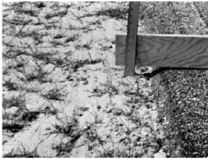
(L): Độ chênh cao giữa mặt đường và lề đường từ 25 mm đến 50 mm.
