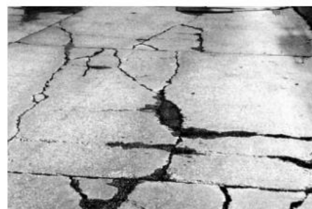
(H): Tấm bị nứt vỡ thành nhiều miếng nhỏ (> 6 phần).
