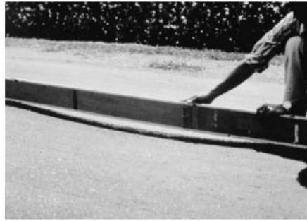
(M): Chiều sâu vết lún cục bộ từ 25 mm đến 50 mm.
