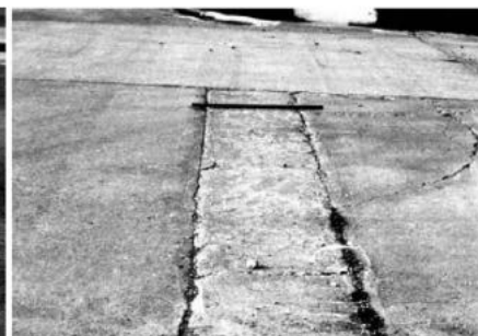
(M): Vết vá bắt đầu bị hư hỏng, quanh mép vá, vật liệu bắt đầu bị rộp vỡ.
