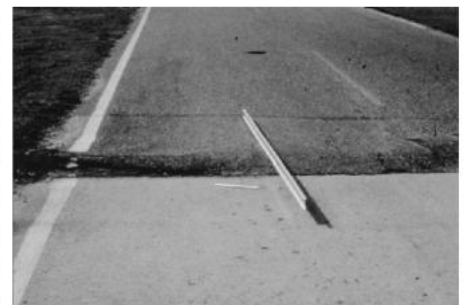
(H): Mặt đường bị đẩy trôi, nhựa dòn cao, ảnh hưởng nghiêm trọng đến chất lượng chạy xe. Lái xe không thể chạy với tốc độ cao do xóc.
