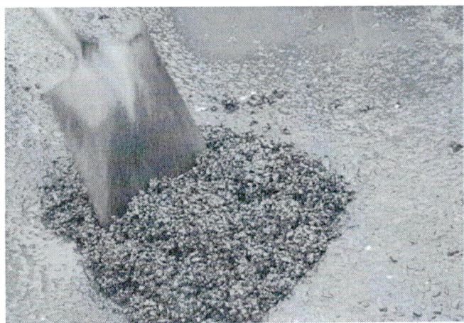
Hình B.3 – Hỗn hợp bê tông nhựa nguội phản ứng với nước ở mặt đường
