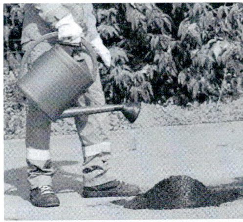
Hình B.4 – Tưới nước để hỗn hợp bê tông nhựa nguội phản ứng với nước
