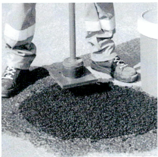
Hình B.6a – Đầm nén bằng đầm tay
