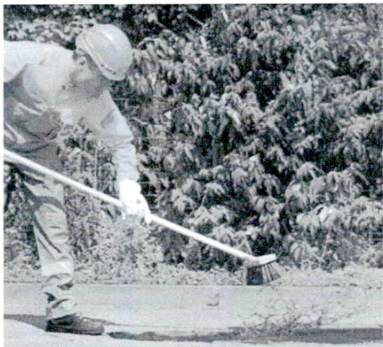
Hình B.1 – Chuẩn bị bề mặt trước khi thi công
