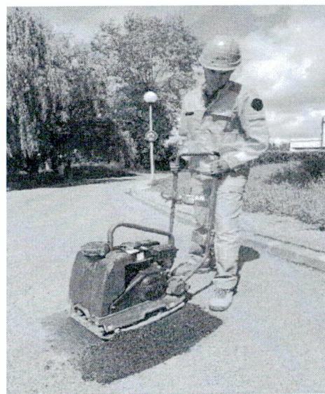
Hình B.6b – Đầm nén bằng đầm bàn
