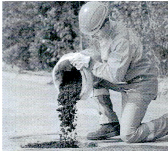
Hình B.2 – Rải hỗn hợp bê tông nhựa nguội vào hố / ổ gà cần vá
