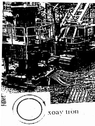
Hình 5-14a: Hạ ống vách bằng phương pháp xoay tròn
