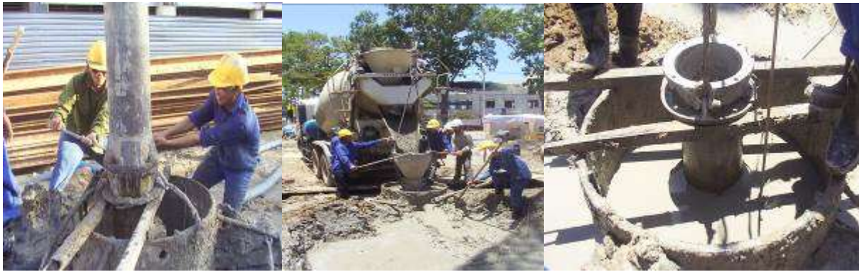
Lắp ống đổ Bê tông, đổ bê tông trong dung dịch Bentonite và đo mặt dâng bê tông
