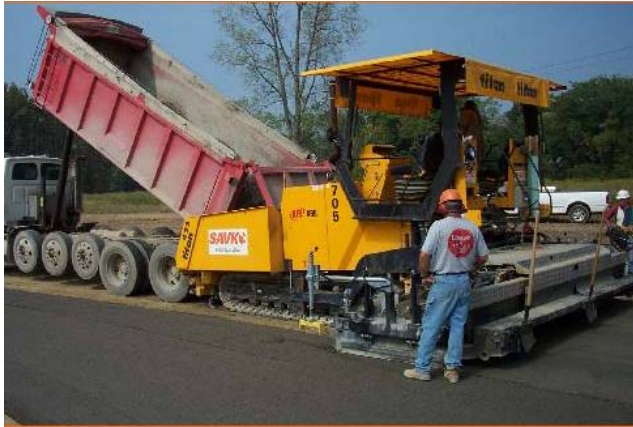
Rải hỗn hợp bê tông đầm lăn bằng máy rải
