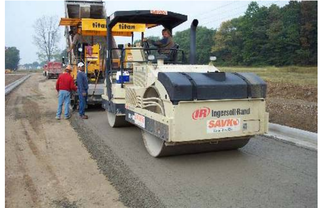
Lu lèn bê tông đầm lăn bằng lu rung
