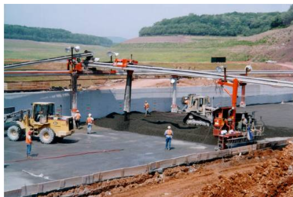
Hệ thống băng tải có ống xả di chuyển hai bên
