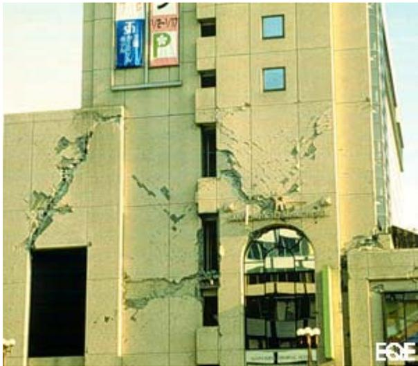
hỏng thường do xuất hiện lực cắt lớn trong dầm và cột khung. Vị trí nơi phá hoại thường xảy ra tại phần cột sát ngay mức trên sàn. Nên làm lưới thép nhỏ ốp quanh chân cột, cột sẽ tăng độ cứng nhiều. Thép dọc chịu mômen âm dù là cốt vằn cũng nên uốn móc  $135^\circ$ , mà nhiều tiêu chuẩn cho rằng với thép vằn không cần uốn móc.
