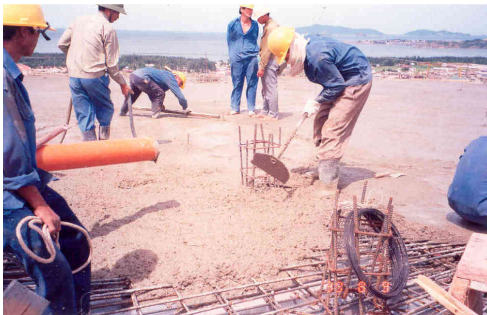
Hình 2.4. Thi công bê tông bơm
