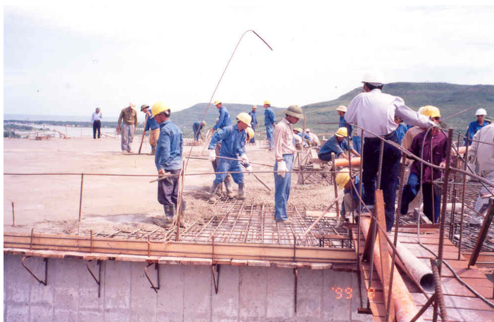
Hình 2.5. Đổ và đầm bê tông bơm
