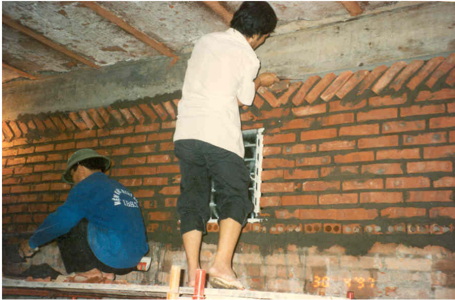
Hình 4.3. Thi công khối xây trong kết cấu khung bê tông cốt thép
