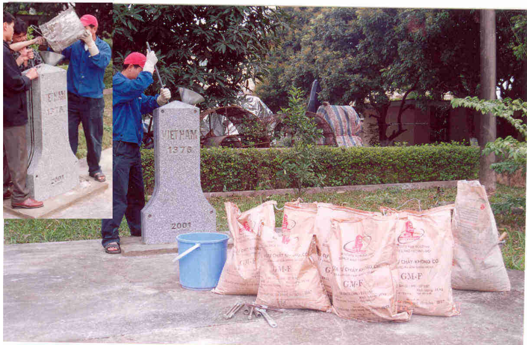
Hình 5.1. Rót vữa tự chảy không co lắp đặt cột mốc biên giới
