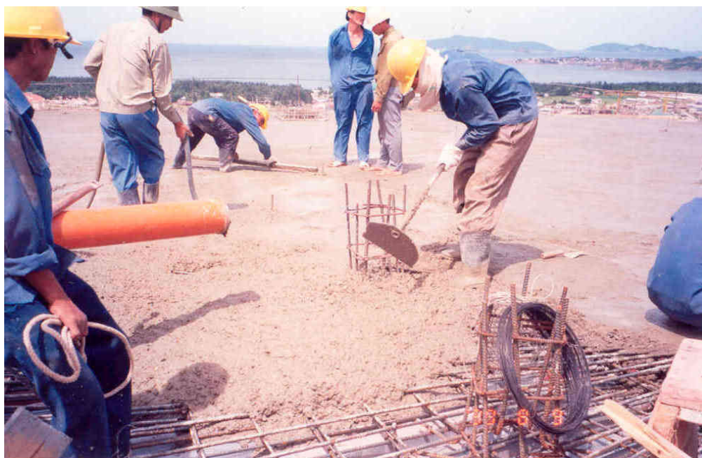
Hình 12.4. Thi công bê tông bơm
