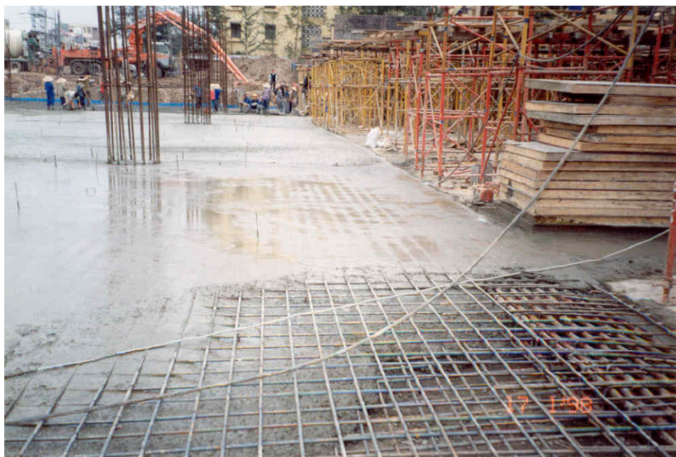
Hình 12.3. Thi công bơm bê tông đổ sàn
