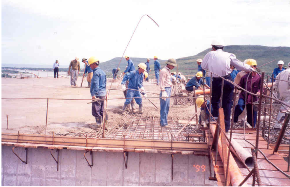
Hình 12.5. Đổ và đầm bê tông bơm
