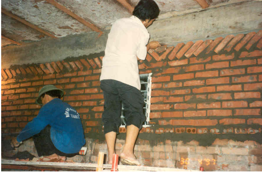
Hình 12.10. Thi công khối xây trong kết cấu khung bê tông cốt thép
