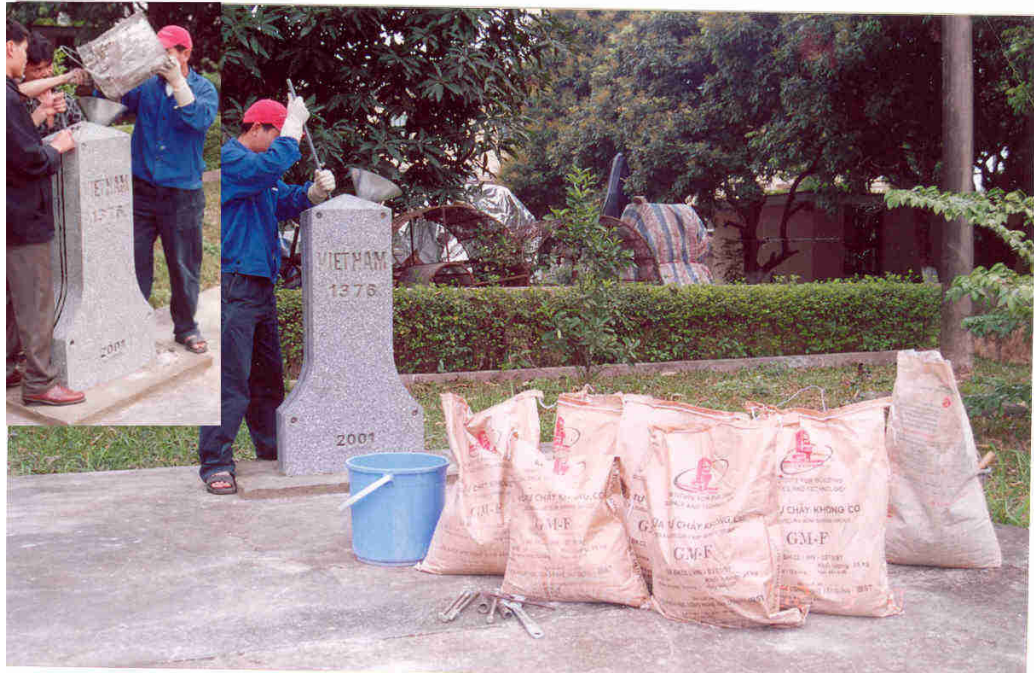
Hình 12.11. Rót vữa tự chảy không co lắp đặt cột mốc biên giới
