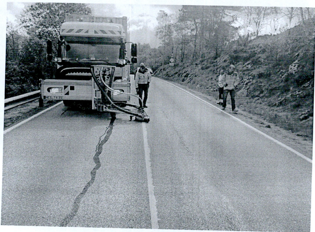
Hình A.2 — Xe thi công xóa vạch kẻ đường theo phương pháp phun bóc
