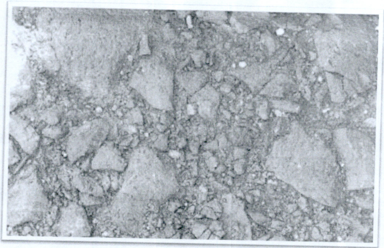
Hình A.1 — Hình ảnh mặt đường sau khi phun bóc
