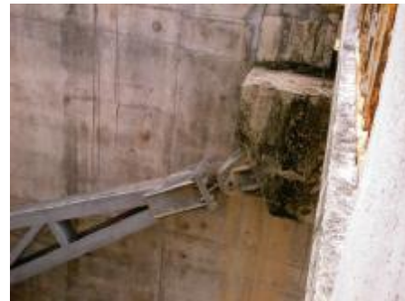
Hình 10.20 cấu tạo van cung
