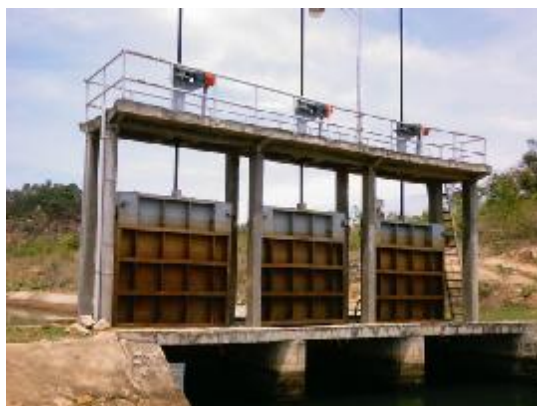
Hình 11.6 Sơ đồ cấu tạo van phẳng thép
